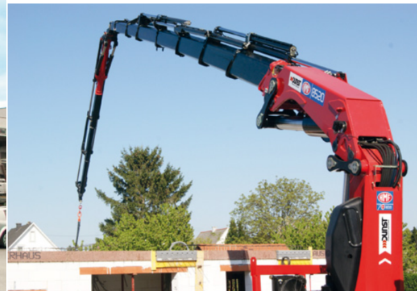
HMF 8520-K8 und FJ1200-K4 Ladekran im Baustelleneinsatz mit einer Reichweite von 34 m bei einer Hubkapazität von 1.700 kg
